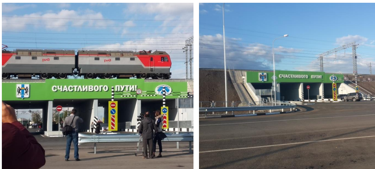
Рис. 3 – Открытие автомобильной дороги с тоннелем под действующими путями 5 сентября 2015 г.
